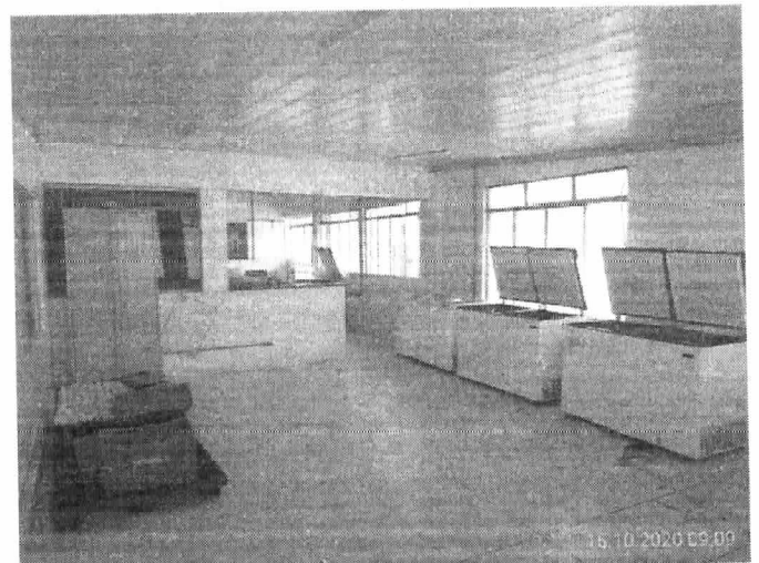
Foto 10: Sala de congeladores
