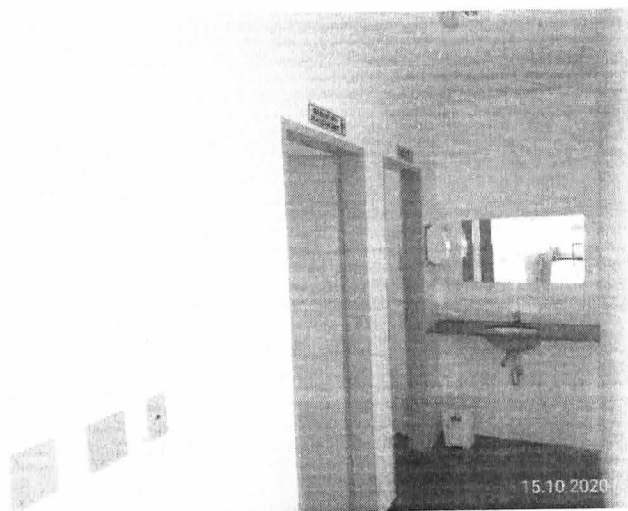
Foto 16: Corredor acesso aos banheiros
