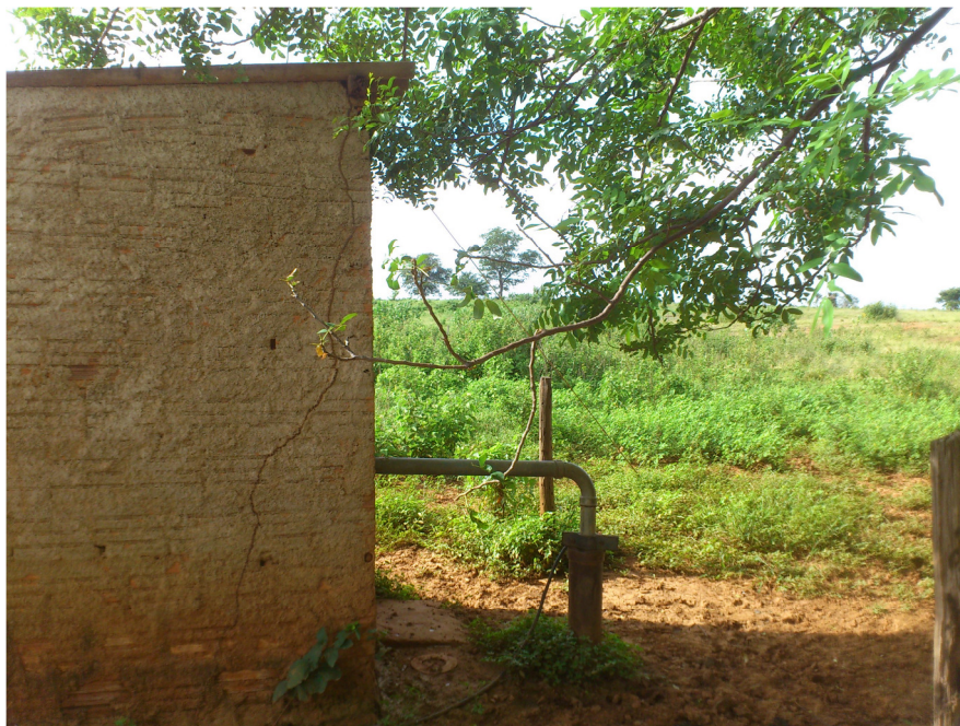
FIGURA 09 TERRENO DO CAMPUS DE JANAÚBA (MG) POÇO ARTESIANO COM CASA DE BOMBA, EM 07/02/2013
