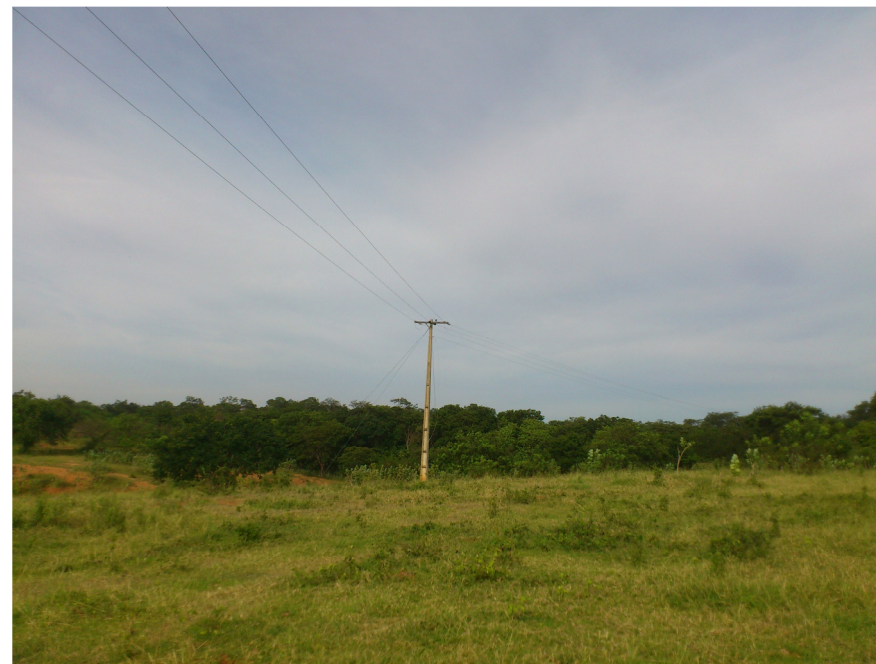
FIGURA 10 TERRENO DO CAMPUS DE JANAÚBA (MG) REDE DE FORNECIMENTO DE ENERGIA ELÉTRICA, EM 07/02/2013
