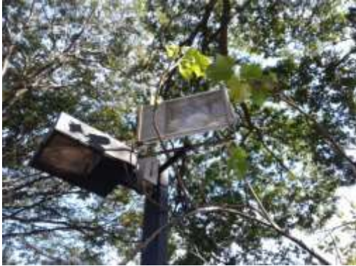
Lâmpada Vapor Metálico 250W - Externa - Avenida Portaria 1 ate Portaria 2 - Poste 71- refletor
