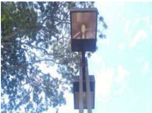
Lâmpada Vapor Metálico 70W - Externa Avenida Portaria 1 ate Portaria 2 - Poste 70
