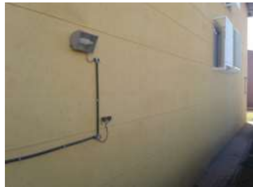
Lâmpada Fluorescente Compacta 105W - Bloco 3Q - Externo
