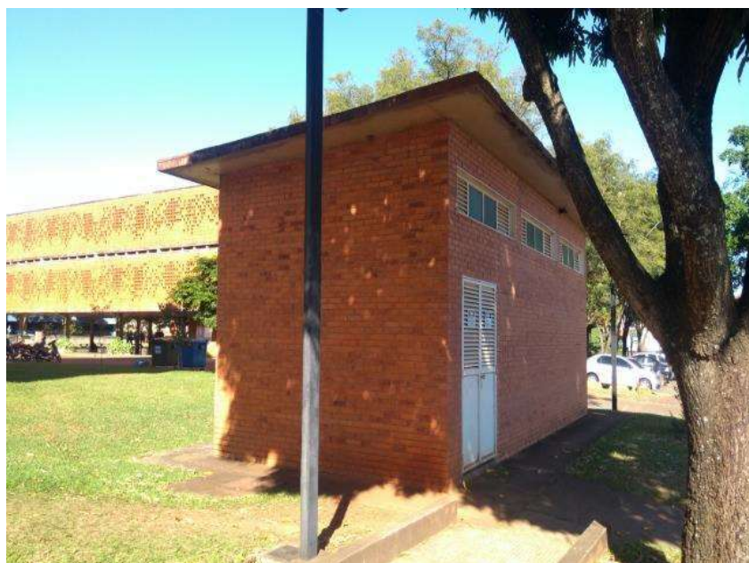
Figura 7.1 - Subestação da universidade
