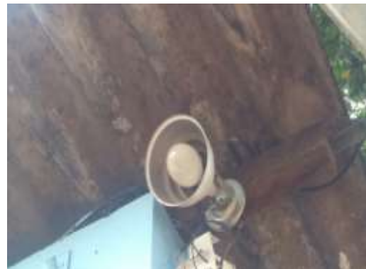
Lâmpada Vapor Metálico 70W - Portaria 2 - Externo
