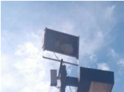
Lâmpada Vapor Metálico 70W - Externa Avenida Portaria 1 ate Portaria 2 - Poste 70
