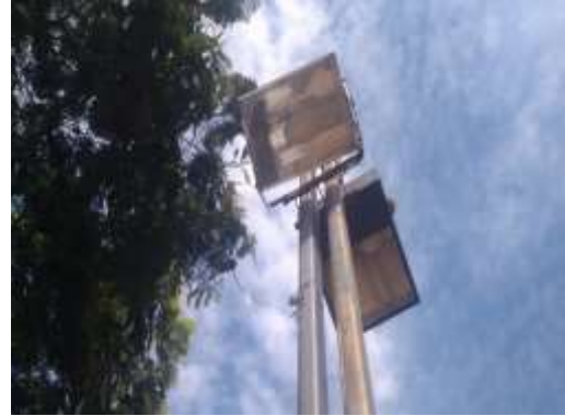
Lâmpada Vapor Metálico 400W - Externo Rua 3 - Poste 5 refletor
