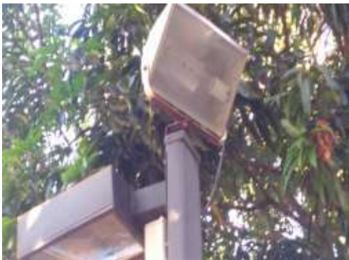
Lâmpada Vapor Metálico 400W - Externo Rua 3 - Poste 21 refletor
