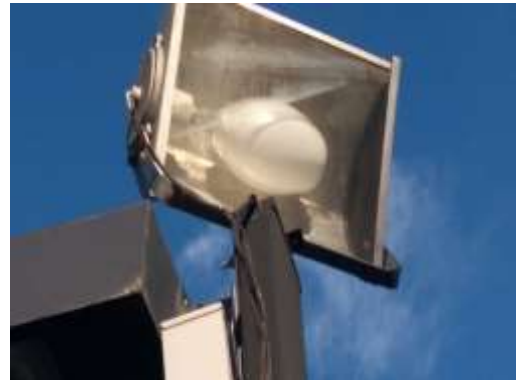
Lâmpada Fluorescente Compacta 105W - Bloco 3Q - Externo
